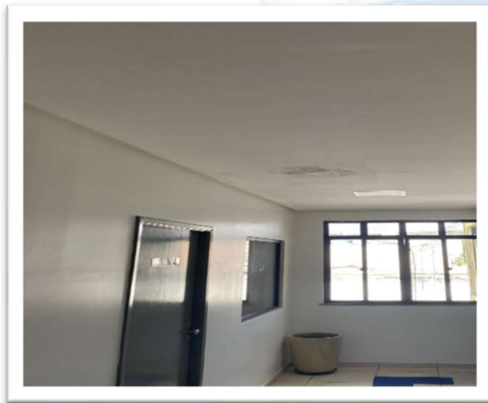
Figura 1: Hall de Acesso a Tesouraria Fonte: Jader Alves Gusmão
