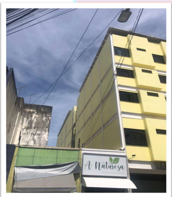
Figura 22: Fachada Esquerda Fonte: Jader Alves Gusmão
